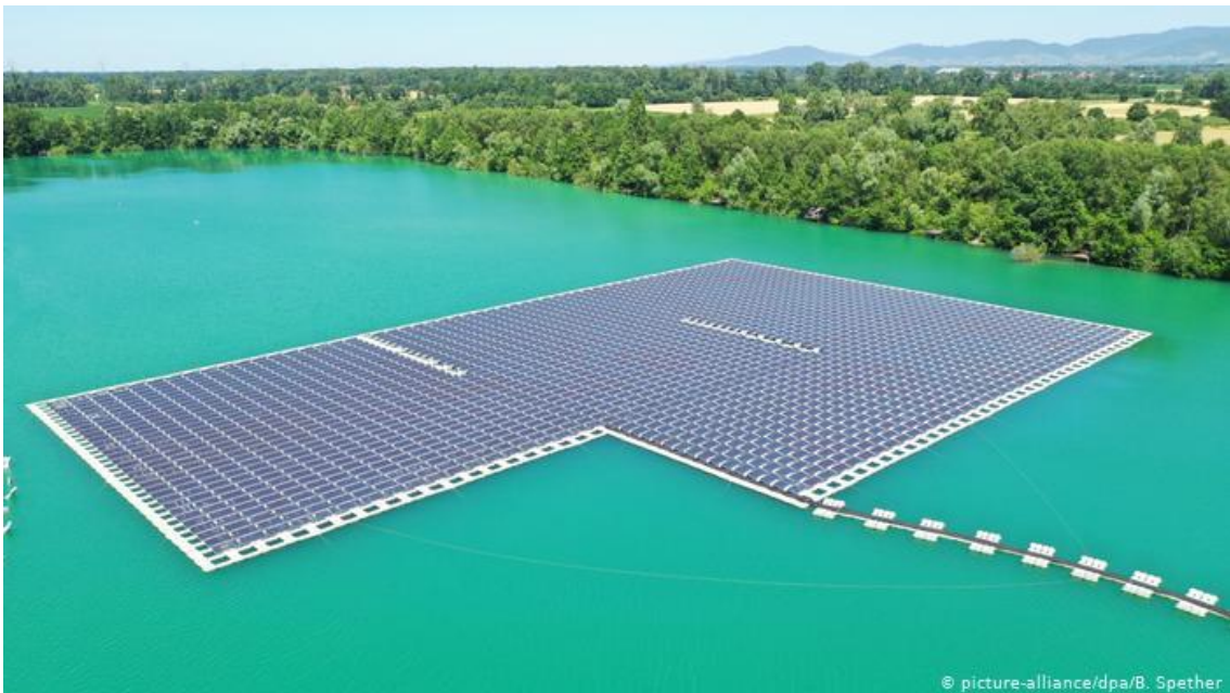
Рис. 8.24. Плавуча сонячна електростанція (Ренхен)
