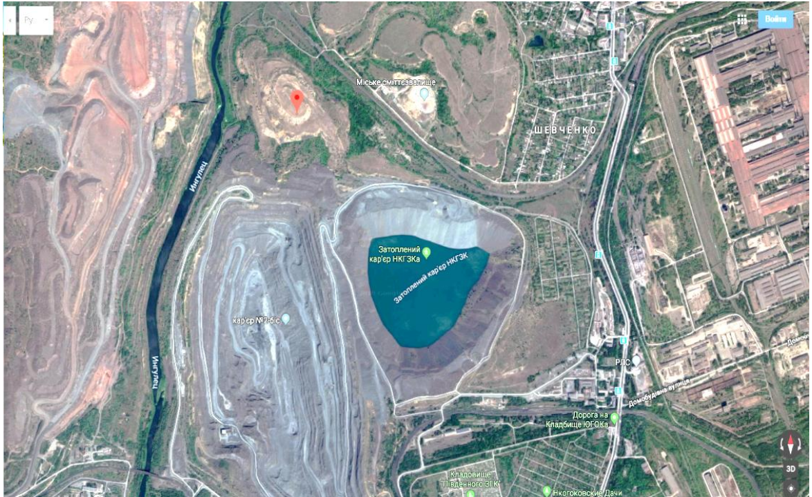
Рис. 8.23. Фотоплан кар'єрного озера Новокириворізьського ГЗК, придатного для застосування як нижнього басейну ГАЕС
