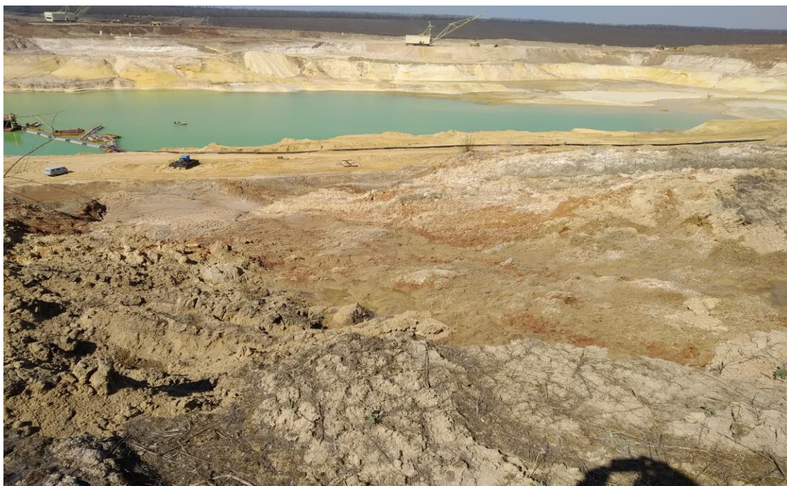
Рис. 4.8. Зсув на борту кар'єру Мотронівського ГЗК
